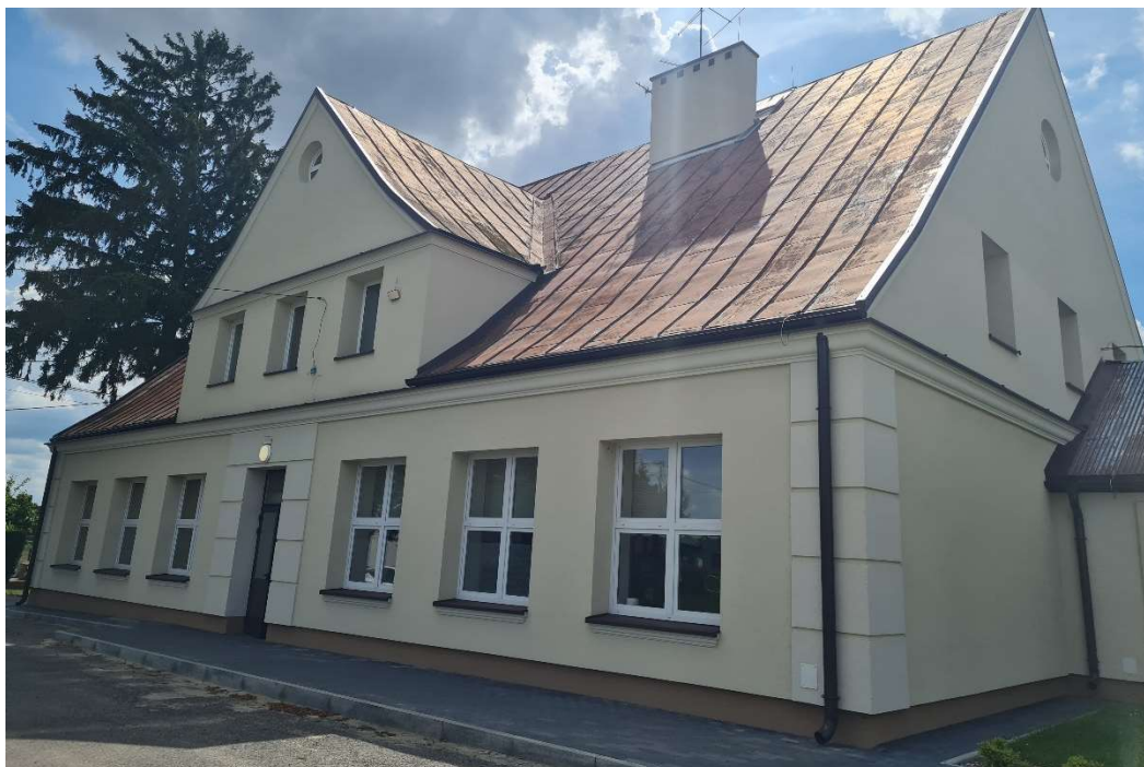
Fot. 1 Segment A: Dach nad szkołą o konstrukcji drewnianej kryty blachą płaską (na rąbek),
