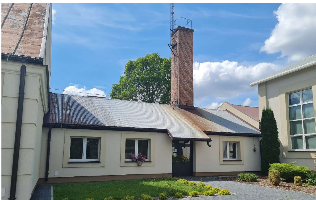
Fot. 2 Segment B: Dach nad łącznikiem o konstrukcji drewnianej pokryty blachą trapezową.
