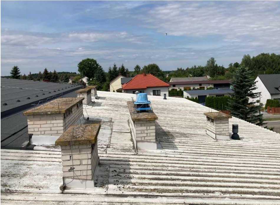
Fot. 1 Dach nad zapleczem Sali gimnastycznej
