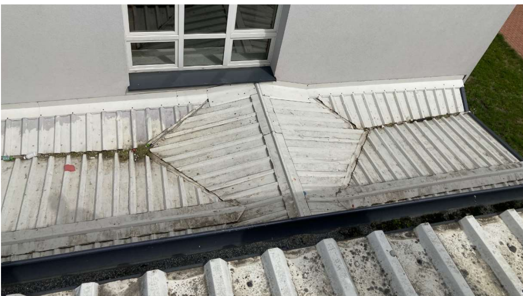
Fot. 2 Dach nad łącznikiem Sali gimnastycznej z budynkiem szkoły
