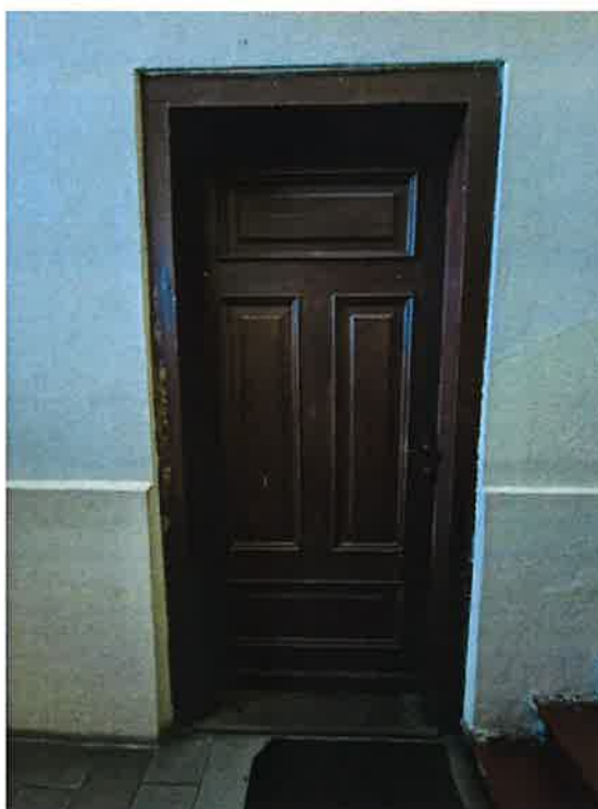
Widok od strony klatki schodowej
