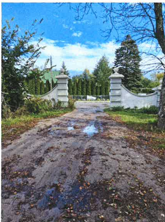
2. Widok na bramę wjazdową od strony zachodniej.
