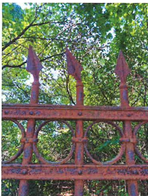
Widoczne zakrzywienie detalu architektonicznego, wymagające naprawy.
