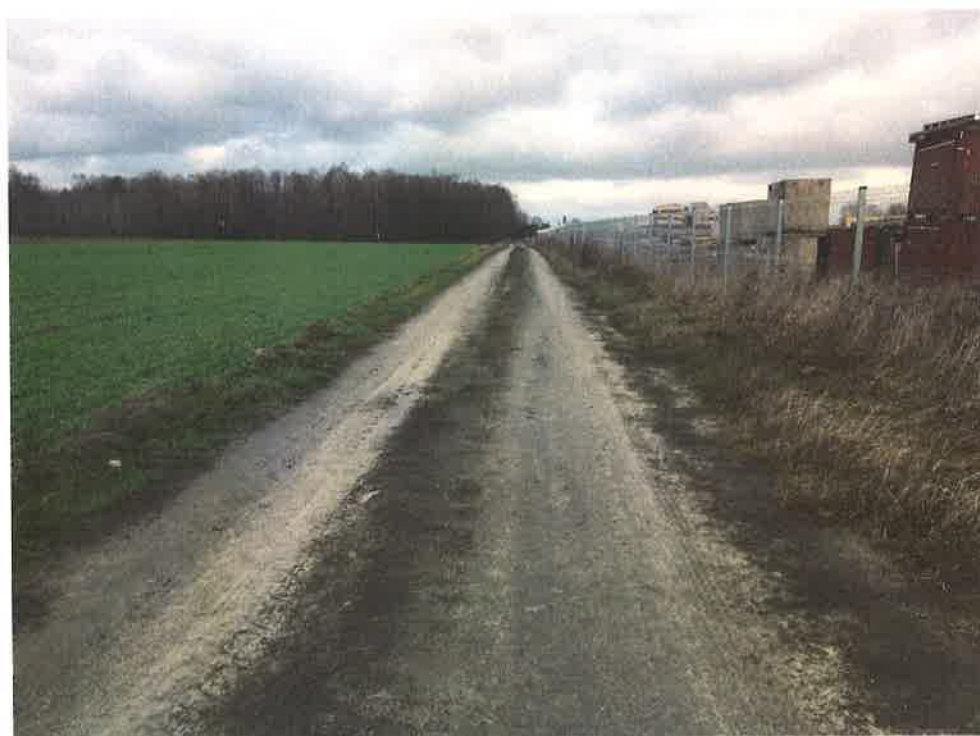
Zdj. 2-4 droga gminna objęta przebudową
