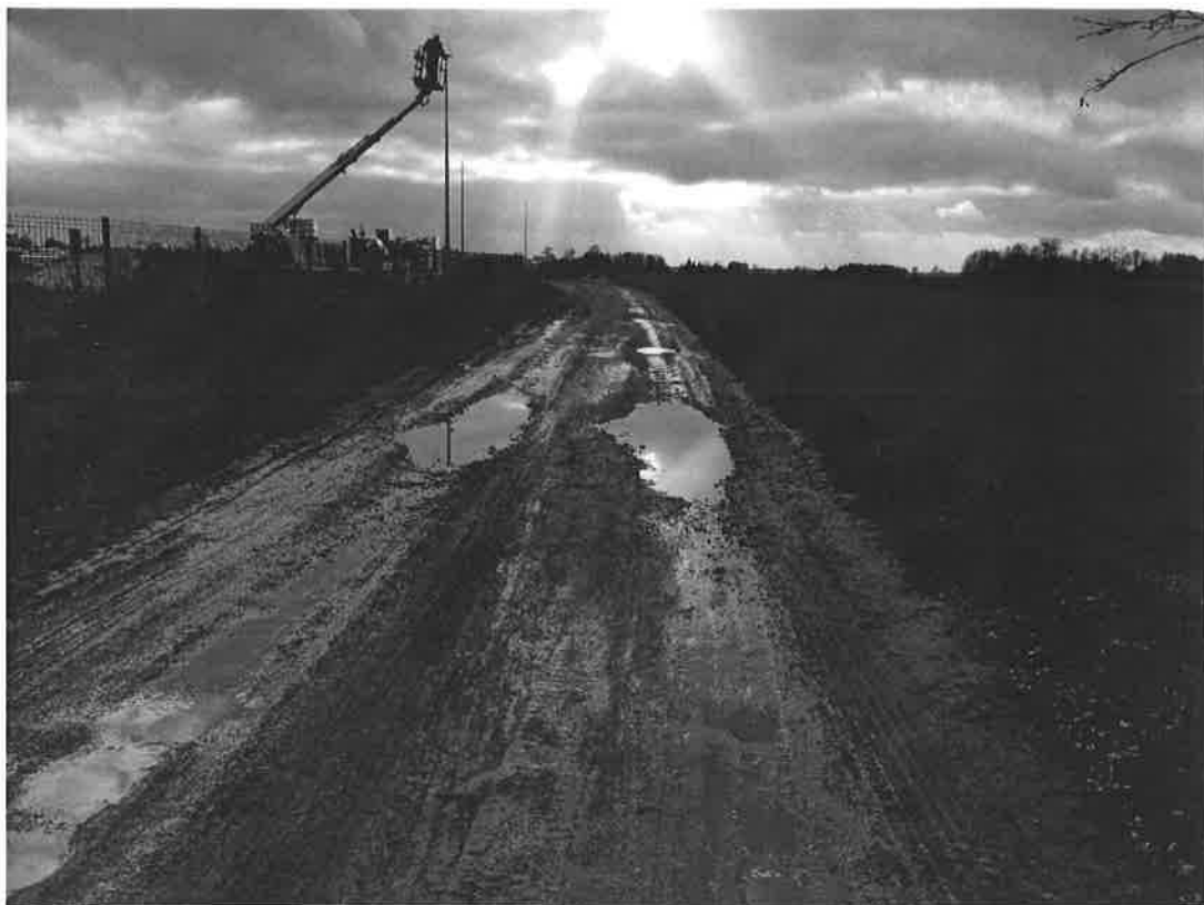
zdj. 2 i 3 droga gminna objęta przebudową
