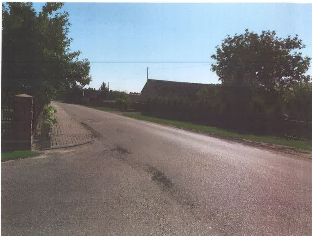
Zdj. Nr 3 droga powiatowa nr 3656W
