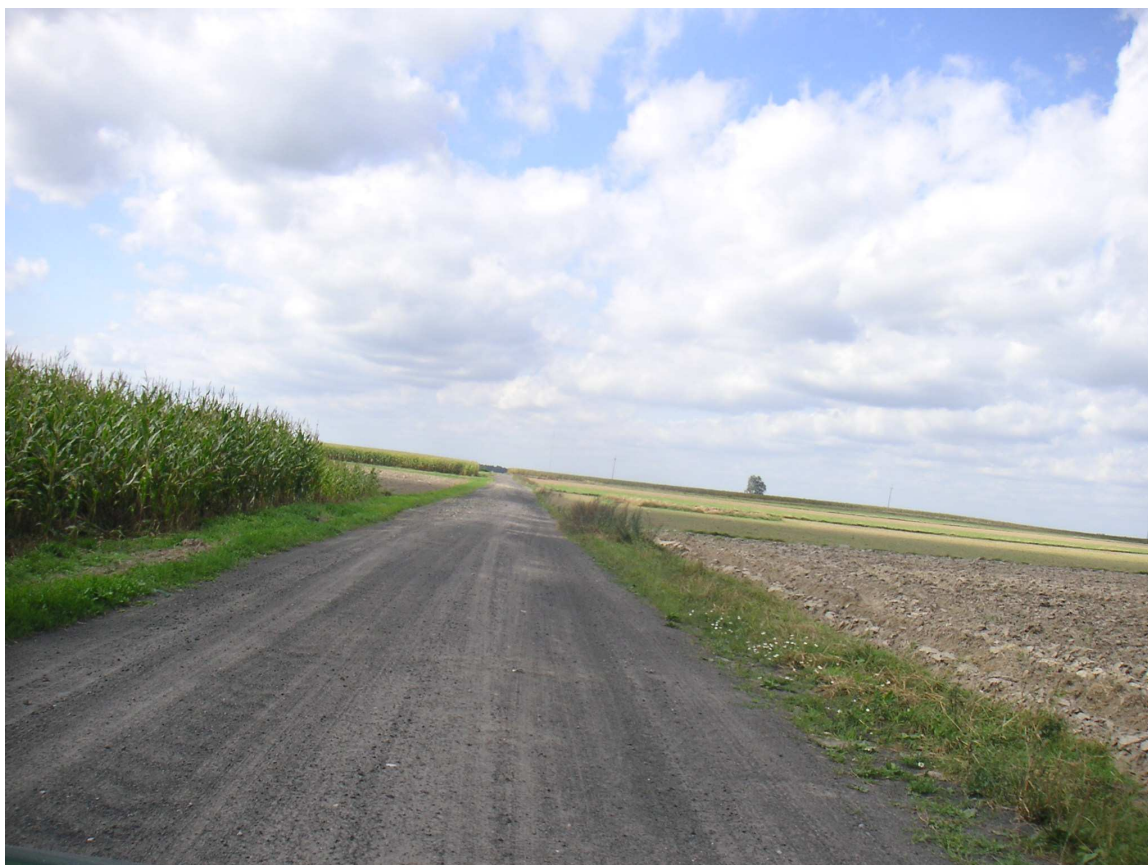
Fot. 1. Widok w km 1+800 w kierunku zgodnym z kilometracją
