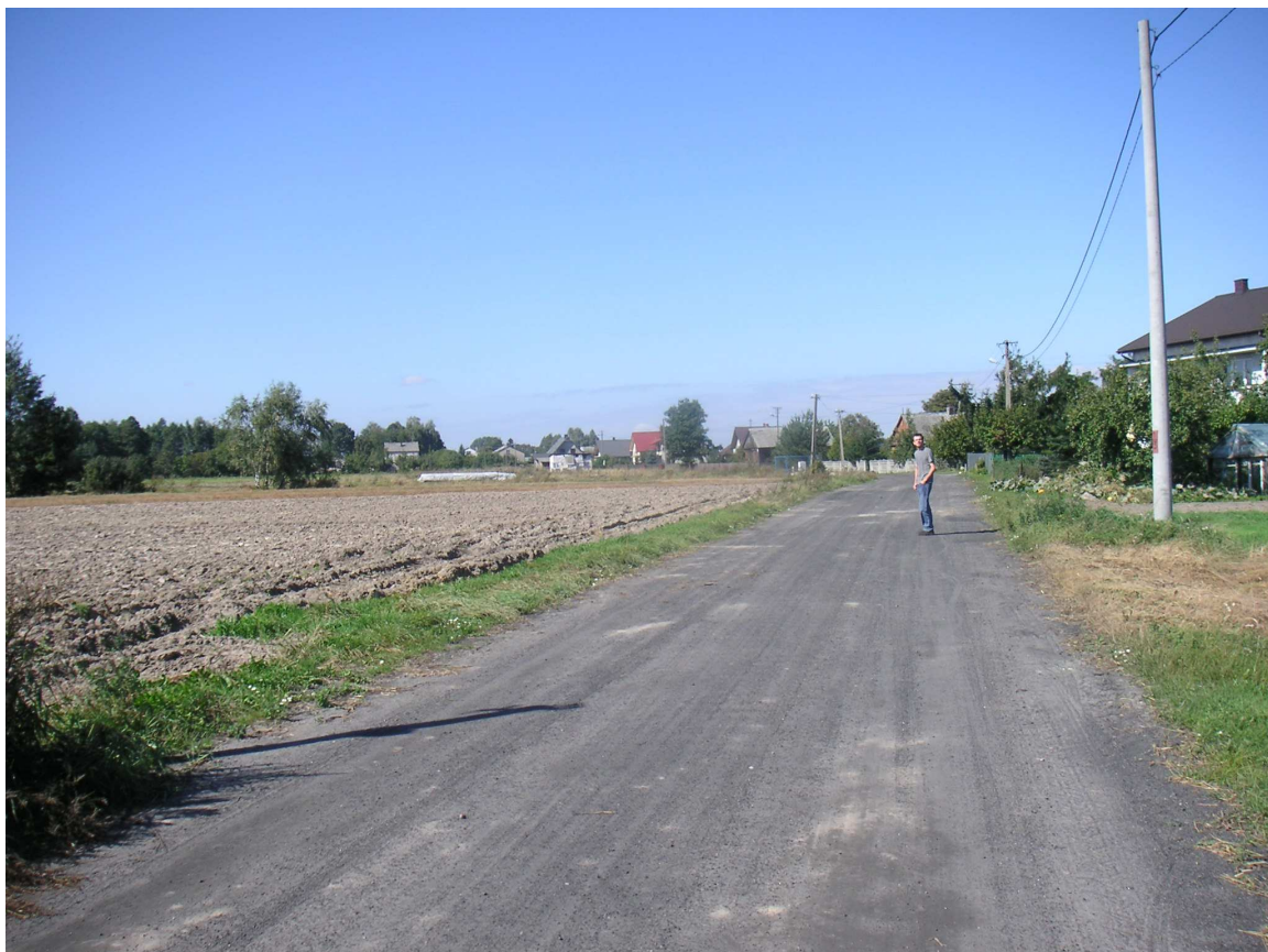
Fot. 1. Widok w km 0+350 w kierunku zgodnym z kilometracją
