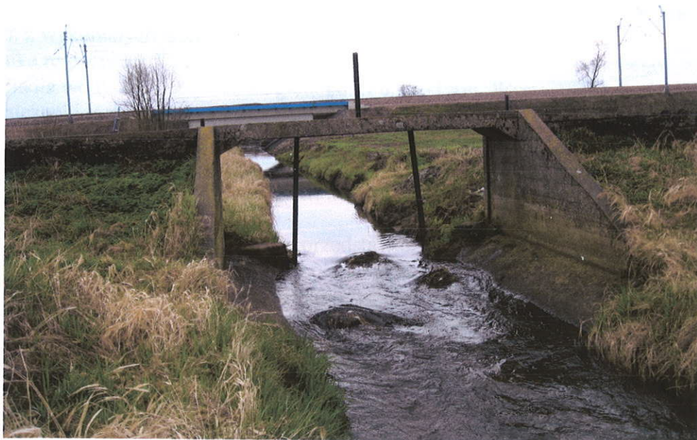
Widok jazu betonowego od wody dolnej
